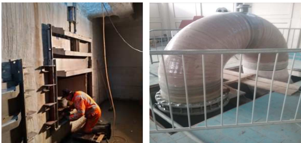
Figuur 2 Nieuwe toevoerafsluiters (links) en de inkomende persleiding (rechts)
