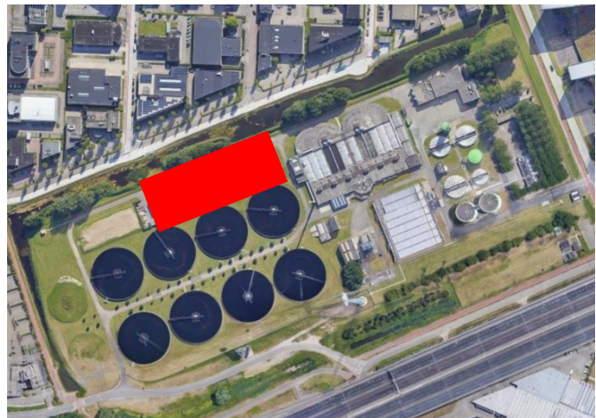
Bovenaanzicht awzi Kralingseveer, met in rood aangegeven de plek van de te vervangen beluchtingselementen in de aëratietank
