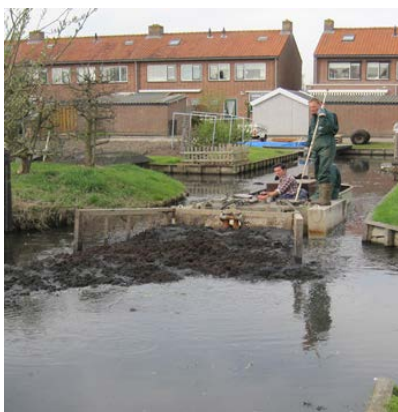
Figuur 7. Baggerwerk in uitvoering
